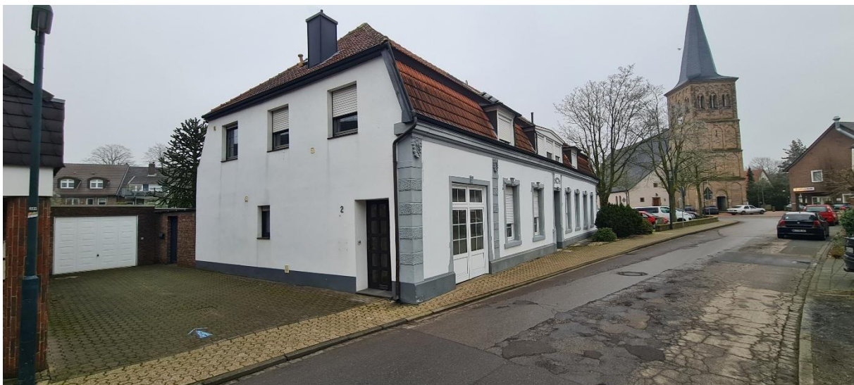
Abb. 4: das betroffene Gebäude (südwestliche Ansicht)
