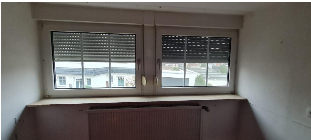
Abb. 10: Fenster mit Rollladenkasten
