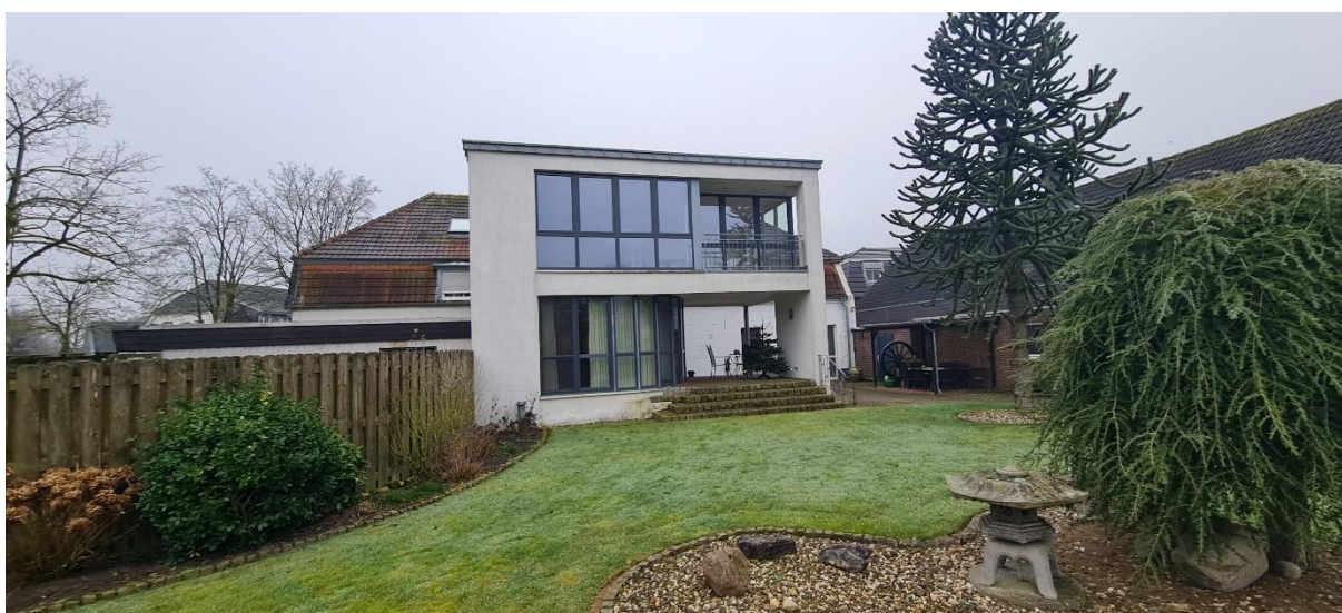
Abb. 6: Außensicht (nordliche Ansicht)
