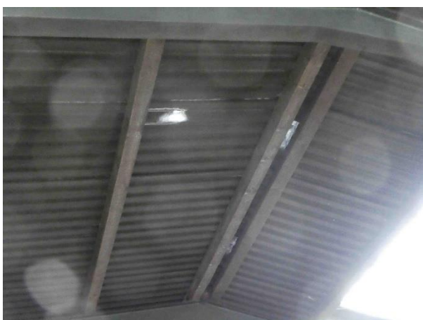
Foto 21: ... das die Eindeckung aus Wellelementen trägt
