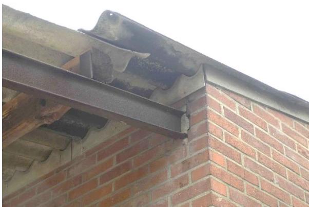
Foto 9: Dacheindeckung geschlossen (keine Hohlräume)
