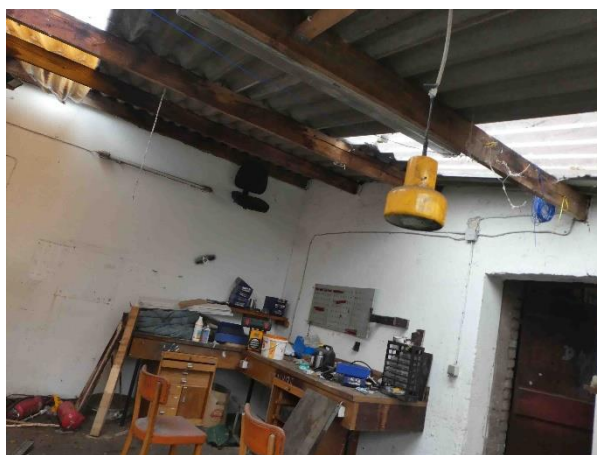
Foto 18: Werkstattnutzung im eingeschossigen Anbau
