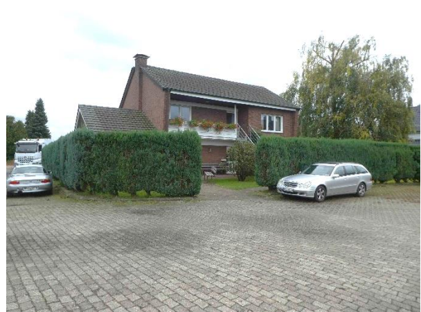
Foto 26: Wohngebäude (bleibt erhalten)
