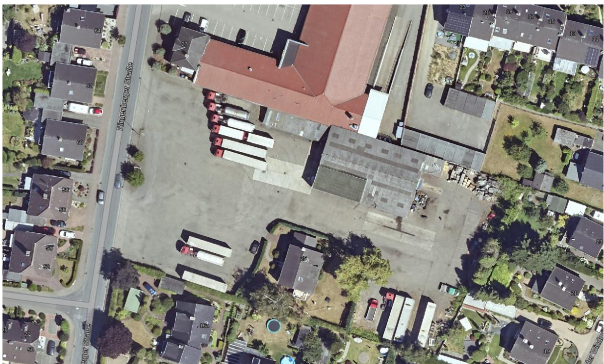
Abbildung 2: Luftbild der Vorhabenfläche, Bildflugdatum 17.07.2022 (Land NRW)
