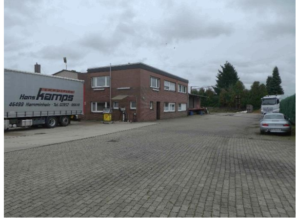
Foto 2: ... auf das Büro- bzw. Hallengebäude
