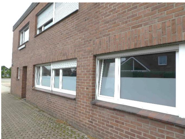
Foto 13: Bürogebäude mit innenliegenden Rollladenkästen, ...
