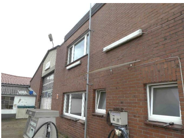
Foto 15: Westfassade des Bürogebäudes (mit Zufahrt in die Halle und Zugang in ...
