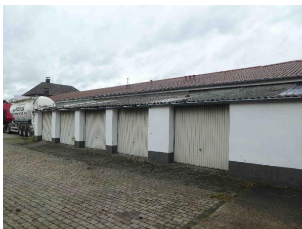
Foto 16: ... einen schmalen eingeschossigen Anbau mit Werkstatt und Garagennutzung)
