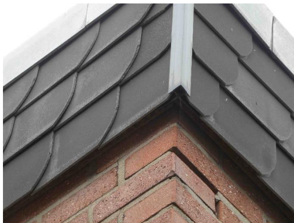
Foto 12: Zierverkleidung (von unten mit Latten verschlossen; Tropfblech eng anliegend)
