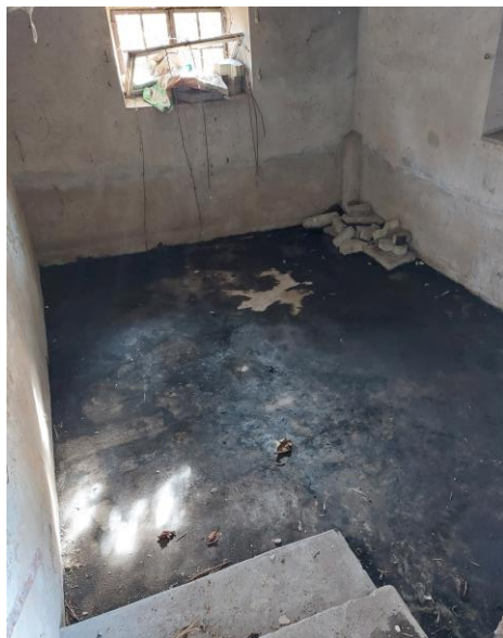
Raum in der Scheune mit Probenahme Kratzprobe K 1.
